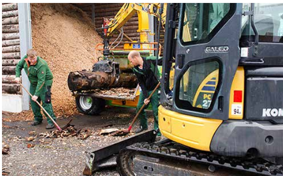
Überdachtes Lager gefüllt mit Hackschnitzeln aus Holzabfällen
