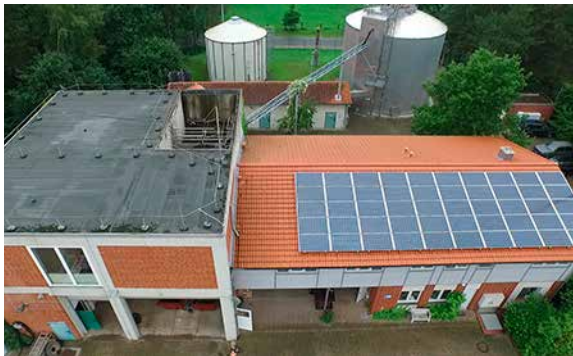
Solaranlage auf dem Dach des Betriebsgebäudes
