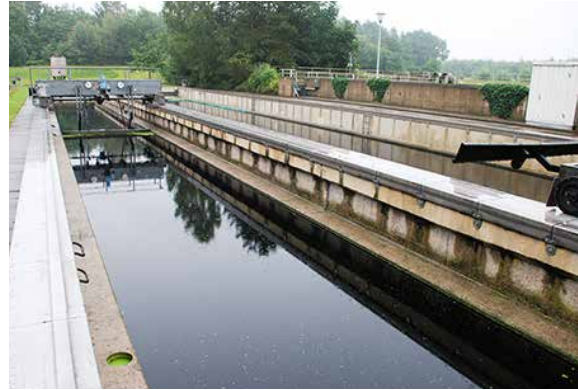
Nachklärbecken in Harsefeld
