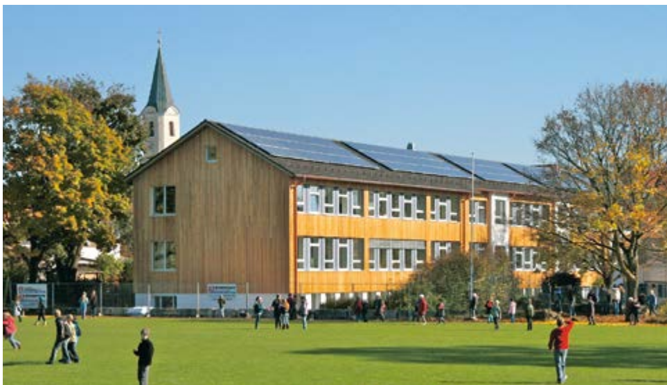
Ein Leuchtturmprojekt auf dem Energie-Lehrpfad: Grund- und Mittelschule in Glonn
