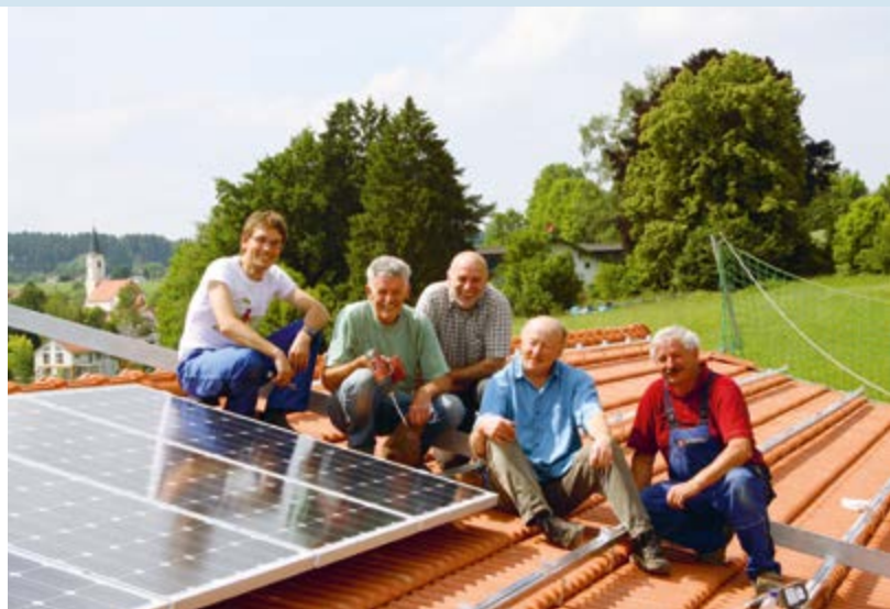
Bau des Bürger-Solarkraftwerks
