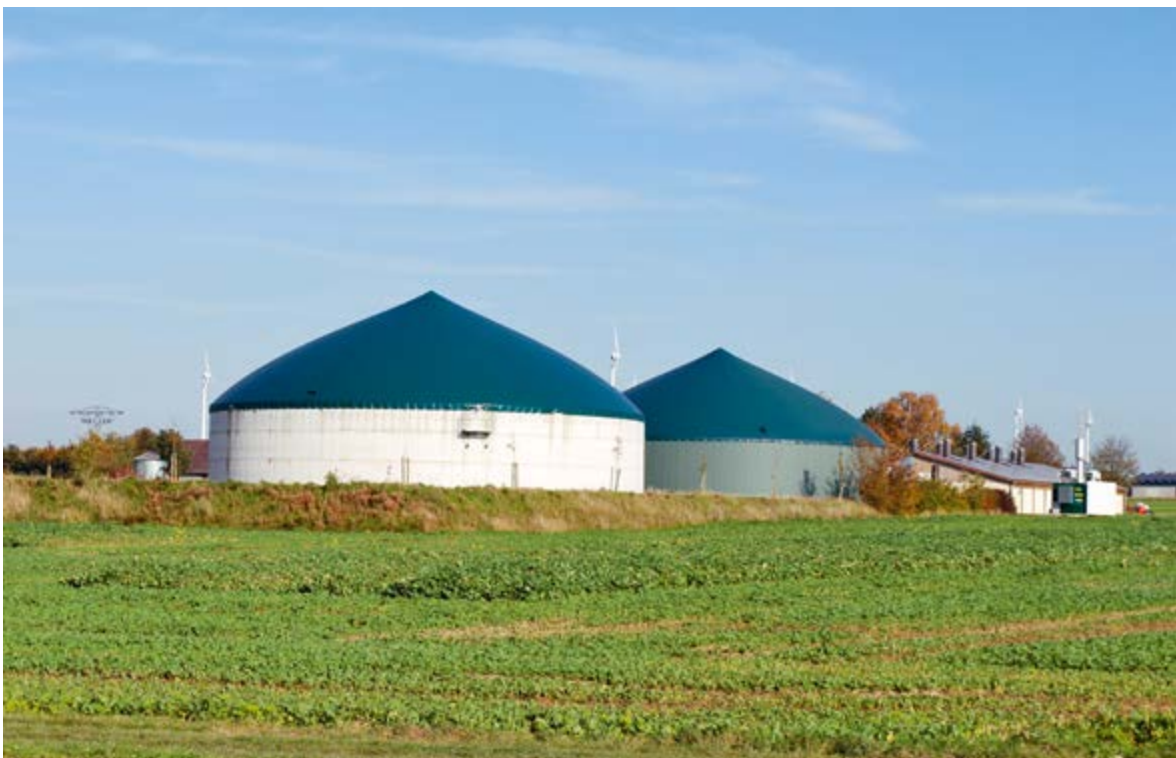
Prägend für die Energieerzeugung in Willebadessen: Biogasanlagen
