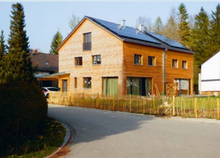
Passivhaus in Glonn
