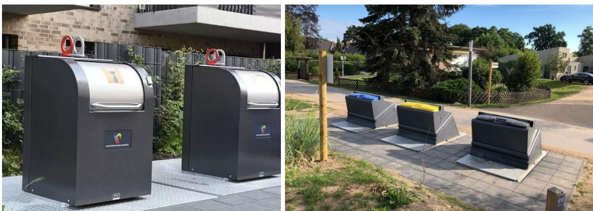
Abbildung 31: Unterflurcontainer – Leerung links mit Abrollkipper und Kran, rechts mit Seitenlader
